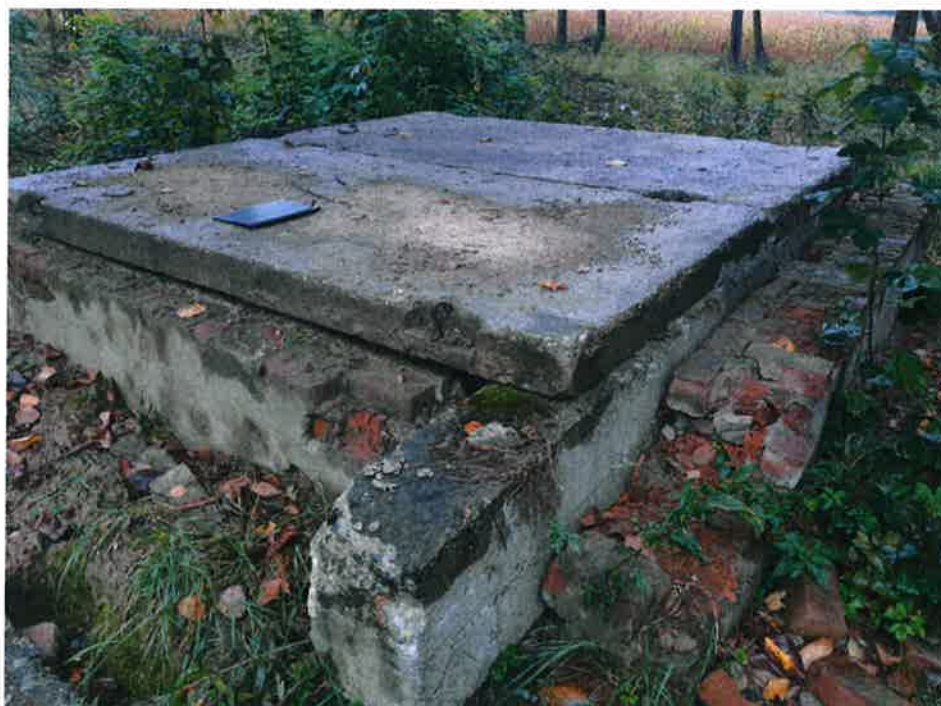
fot.3_ Widok na komorę zasurową
