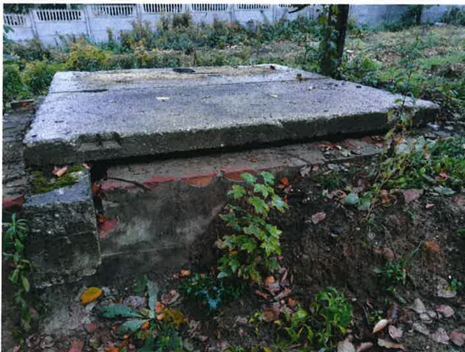
fot.2_ Widok na komorę zasurową
